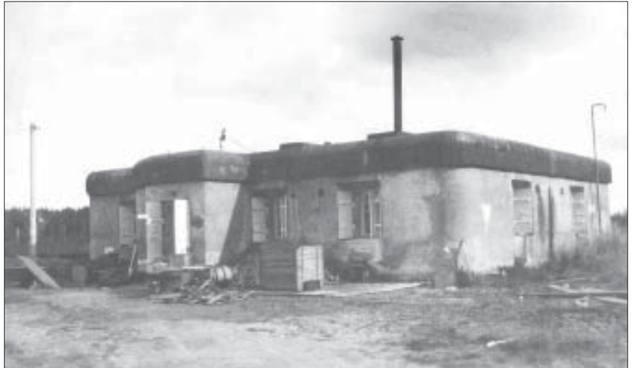
Boden Radios stationshus uppfört 1916.
