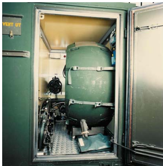
Förvaringsfack för antenn, OBS de speciella "fingrarna" på dörren som ger EMP-tätning.
