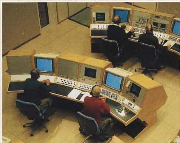
Ledningscentralen vid RFN i Vidsele.
