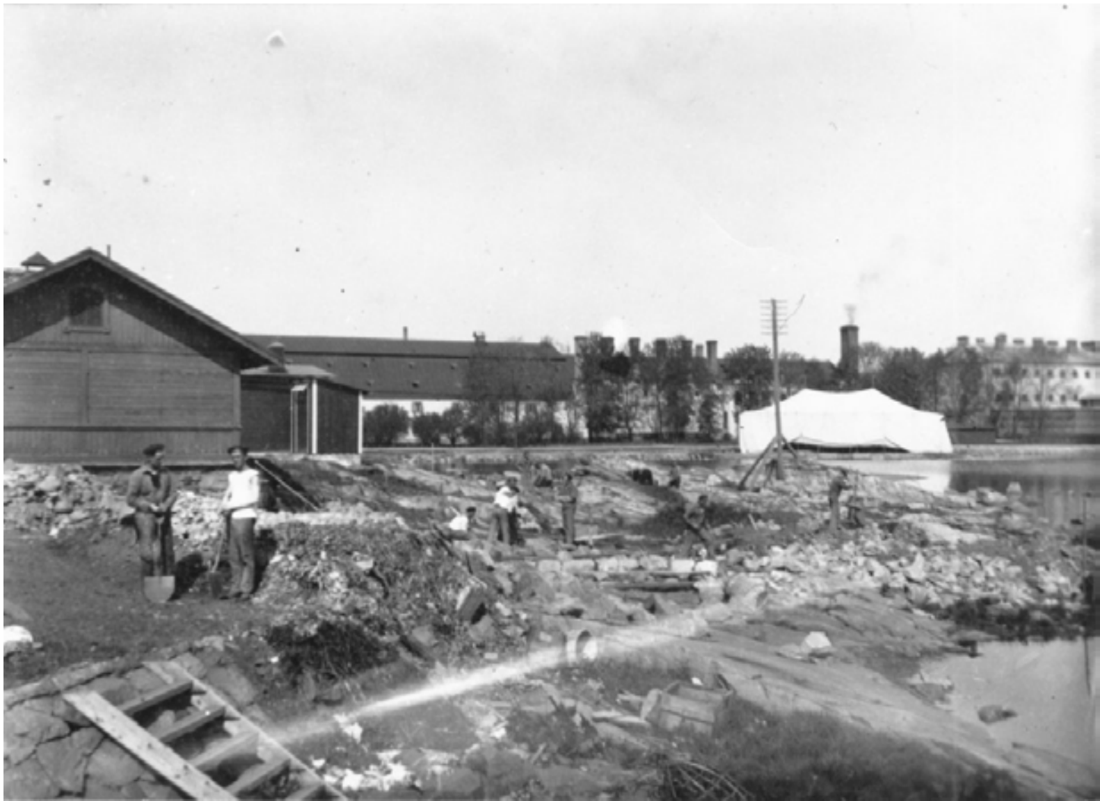
Den gamla hangaren på Stumholmen vid Karlskrona Flygstation började byggas 1915-1916.
