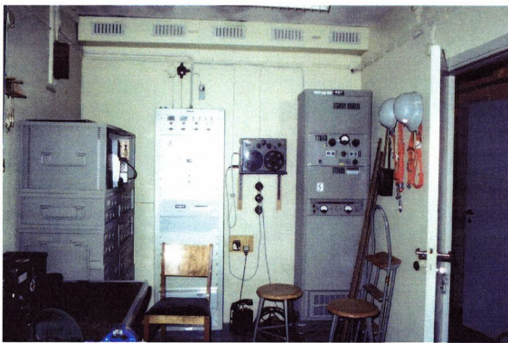
Ett par bilder från dagrummet och telerummet. Till vänster syns luforsändaren RT-01 med manöverstativ och bandspelare. Nedan syns likriktare, signalstativ och KK till vänster och signalomvandlarstativen till höger.
