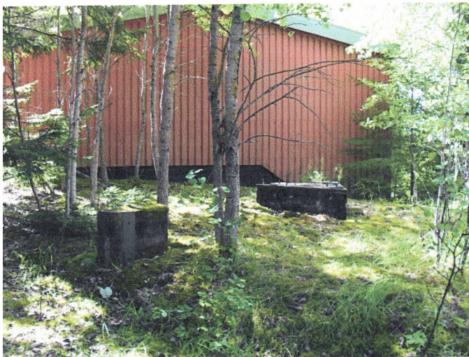
Mastfundamentet för länkmasten finns kvar.
