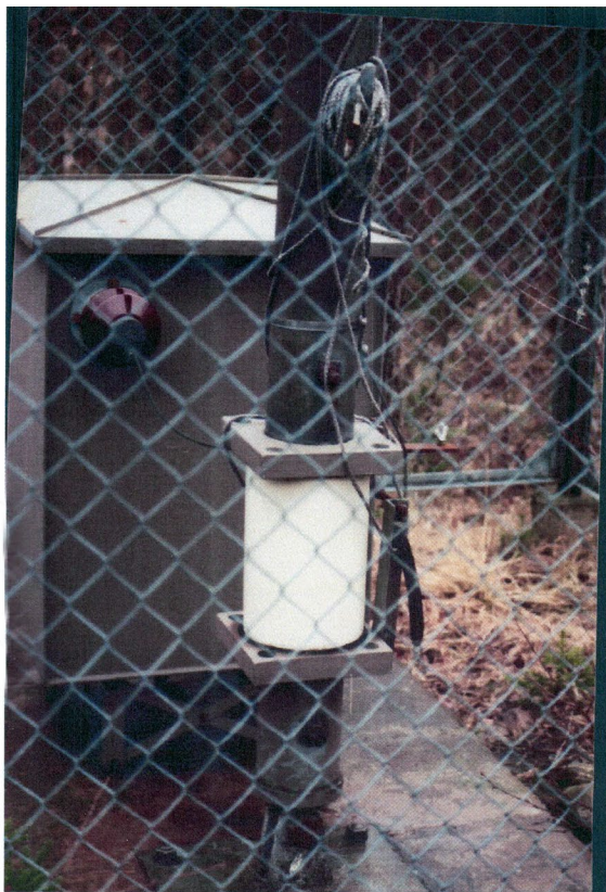
Matningen från högeffektantennanpassningsskåpet till en anslutning ovanför isolatorn. Parallellt över isolatorn sitter ett gnistgap, se högra övre bilden. Masten var 36m hög och på högra nedre bilden syns en av 9 topplinestolpar. Rörmasten bestod av 6 sektioner. Kedjorna på bilden nedan är spännanordning för staginorna, från sex nivåer till tre stagfundament.
