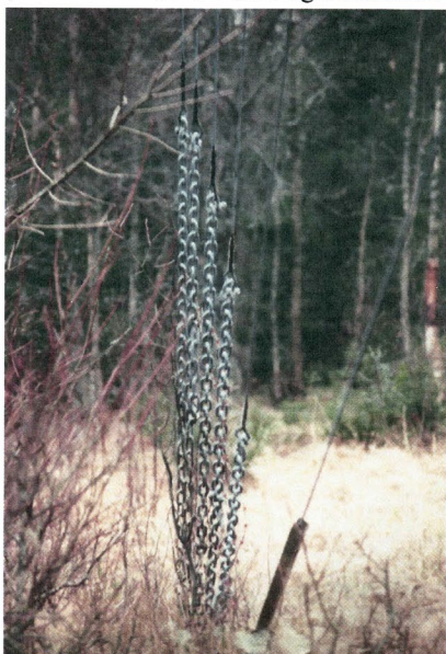
Matningen från högeffektantennanpassningsskåpet till en anslutning ovanför isolatorn. Parallellt över isolatorn sitter ett gnistgap, se högra övre bilden. Masten var 36m hög och på högra nedre bilden syns en av 9 topplinestolpar. Rörmasten bestod av 6 sektioner. Kedjorna på bilden nedan är spännanordning för staginorna, från sex nivåer till tre stagfundament.
