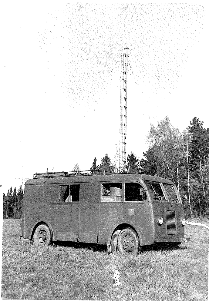
Fig 34 Antennanläggningen Masten reses
