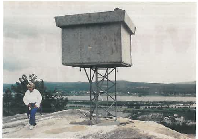
Ls-torn, ståltorn, som var en av monteringsplatserna för tonsvararen. Detta torn står på Luppiberget i Tornedalen och bevakar hukande även Finland, som är på andra sidan Torneälven.
